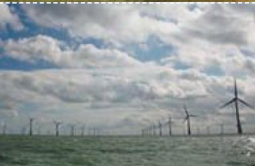
Der Offshore-Windpark Thanet liegt zwölf Kilometer nordöstlich der Themsemündung. Er besteht aus 100 Windkraftanlagen vom Typ Vestas V90 und wird von Vattenfall UK betrieben. Der Rotordurchmesser der einzelnen Anlagen beträgt jeweils 90 Meter; die Generatoren erzeugen eine elektrische Nennleistung von je 3 MW, insgesamt etwa 300 MW. Der Park steht auf einer Fläche von etwa 35 Quadratkilometern. Die Nordsee hat an dieser Stelle eine Wassertiefe von 20 bis 25 Metern.
